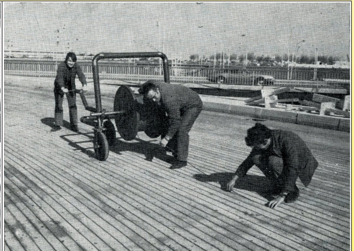
1968 Installazione del nastro scaldante su una rampa di accesso a una piattaforma di parcheggio per autobus, all'aeroporto di Orly, vicino a Parigi (Electric heating of the roadways, by Robert Félix, 1971, Ultimheat Museum*)
